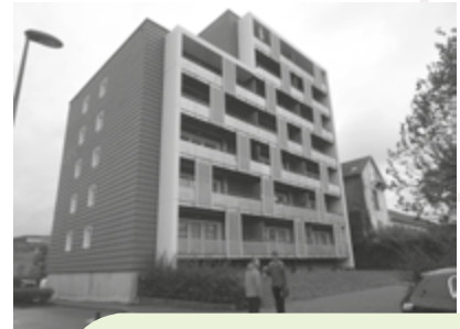
Exemple de projet de logement social en bois-paille à St Dié-des-Vosges
